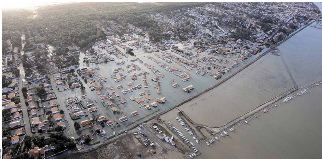
La Faute-sur-Mer, après le passage de la tempête Xynthia, février 2010.
