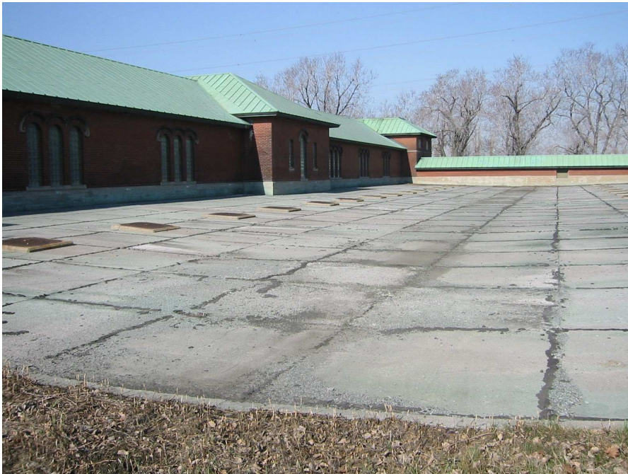
Usine de filtration Atwater, Galeries des filtres avant verdissement
