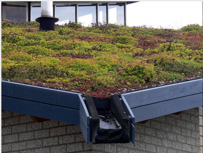
Toiture végétalisée Culemborg (NL)
