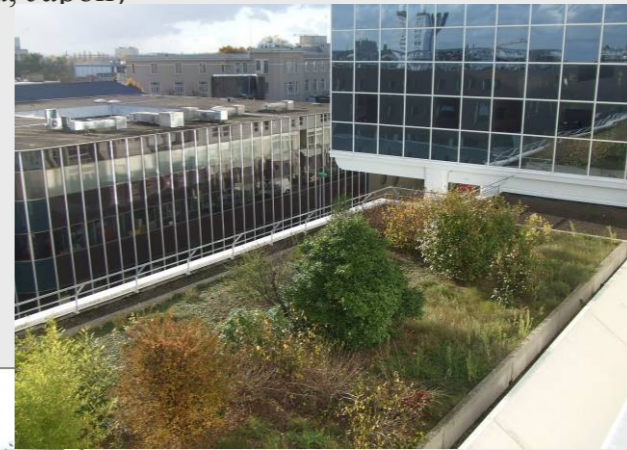
Toiture végétalisée CHU Rennes (F)
